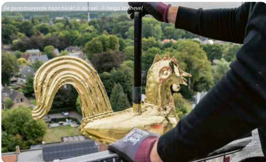
De windhaan prijkt opnieuw op de toren van de kerk © Helga Vanhevel
