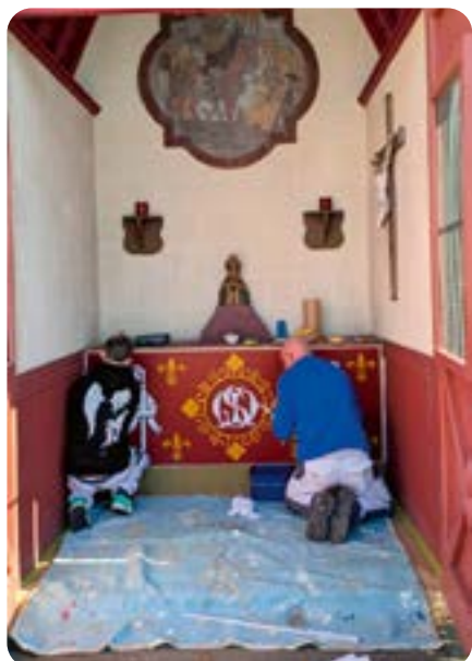
De leerlingen en leerkrachten van het VTI Brugge aan het werk - © Annelies Roels
