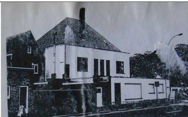
Achterzijde gemeentehuis vóór verbouwing, ca. 1996 (G.A. Zedelgem).
