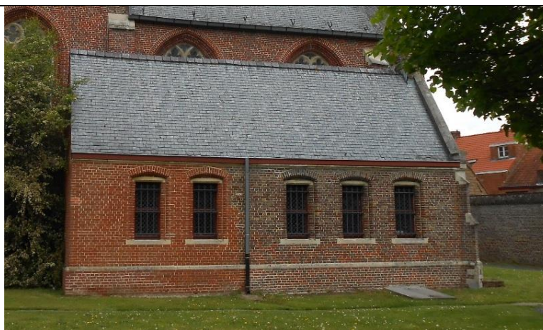
De Z-gevel van de sacristie (© M in O).
