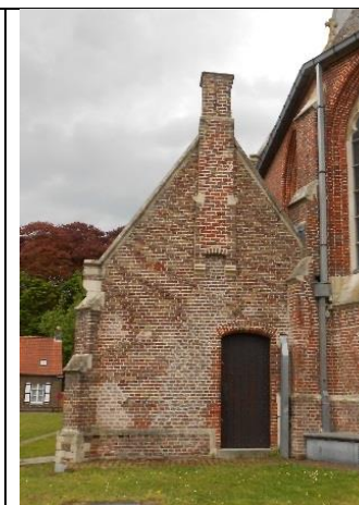
De O-topgevel van de sacristie (© M in O)
